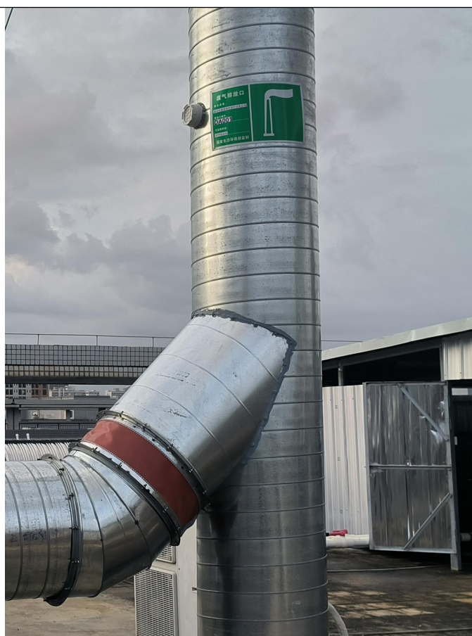
图 13 项目注塑废气收集及处理设施现场照片
