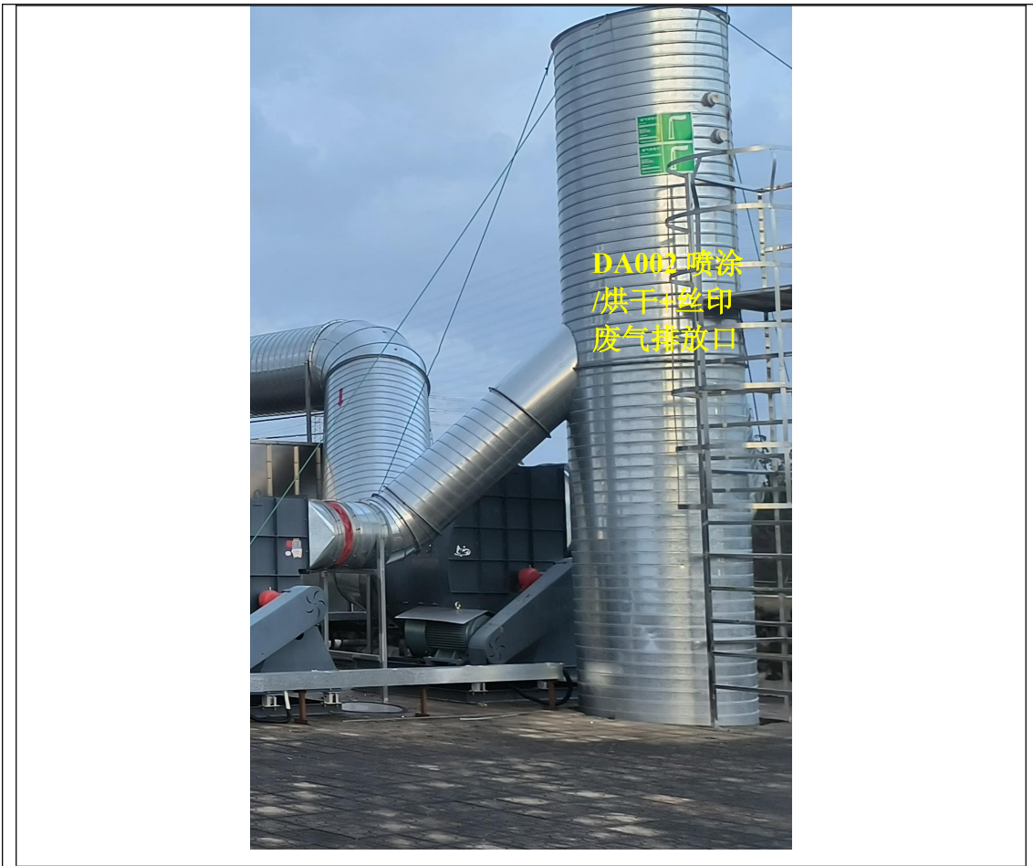
图 18 项目喷涂/烘干/调漆、丝印废气处理设施现场照片 表 12 项目喷涂/烘干/调漆、丝印废气处理设施情况一览表
