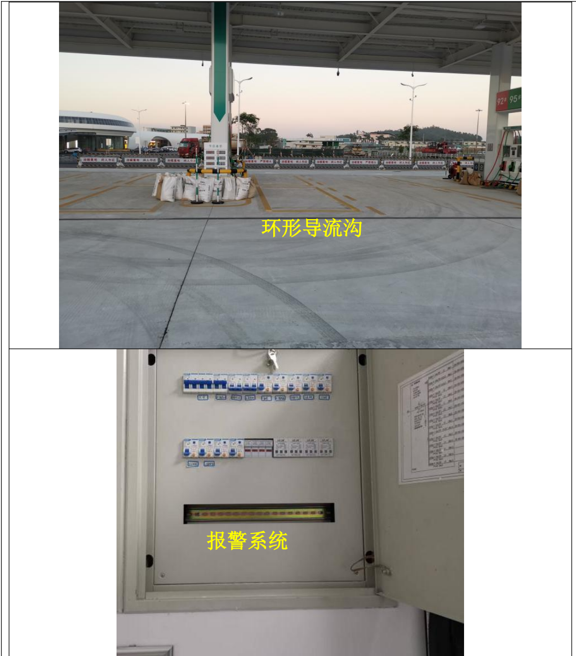
图 14 项目风险防范措施现场照片
