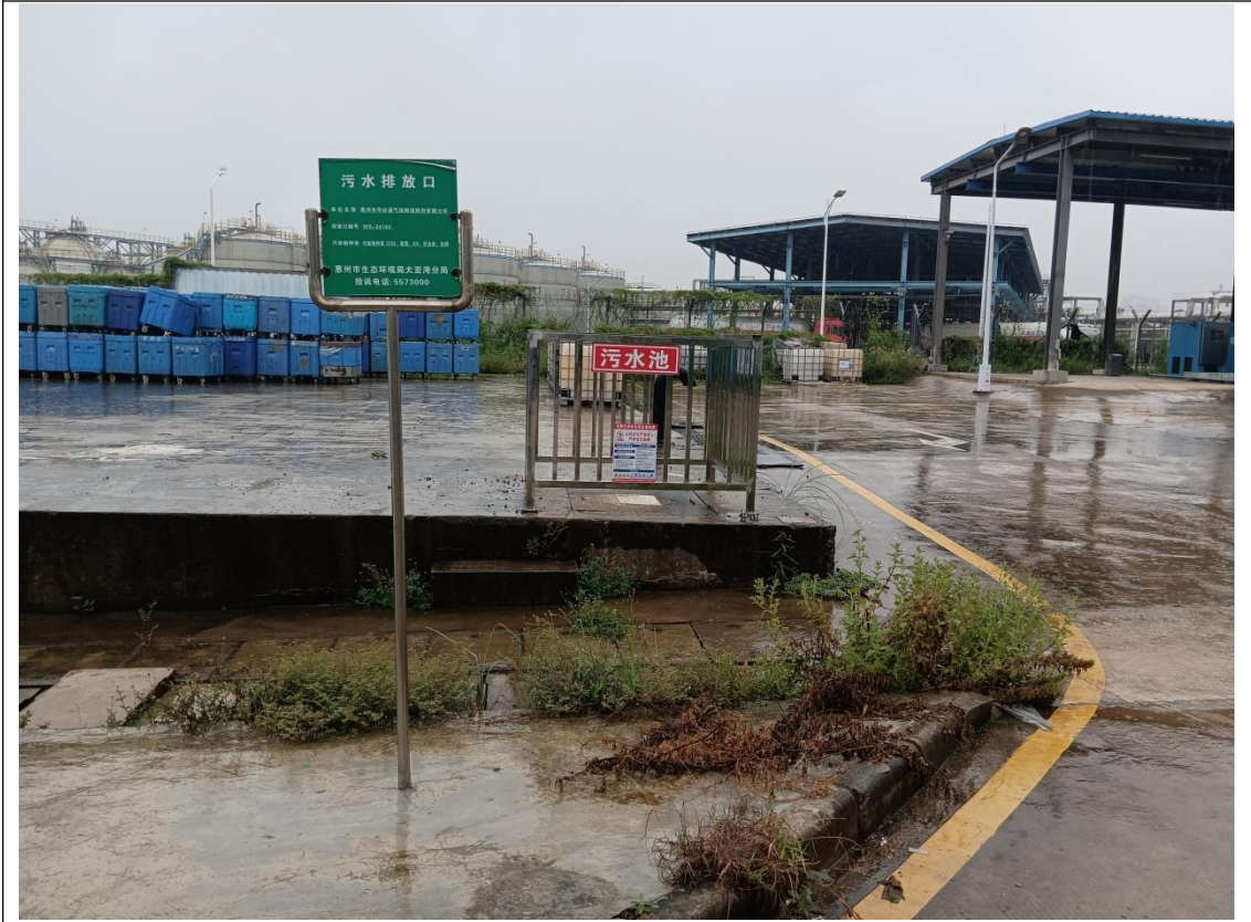
图 4.1-1 污水收集池及排放口现场照片
