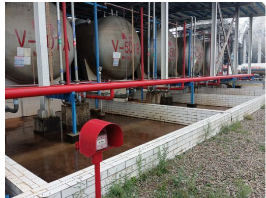
氨水储罐围堰
