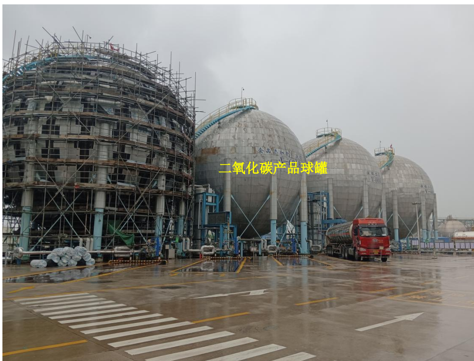
图 3.7-4 生产装置现场照片
