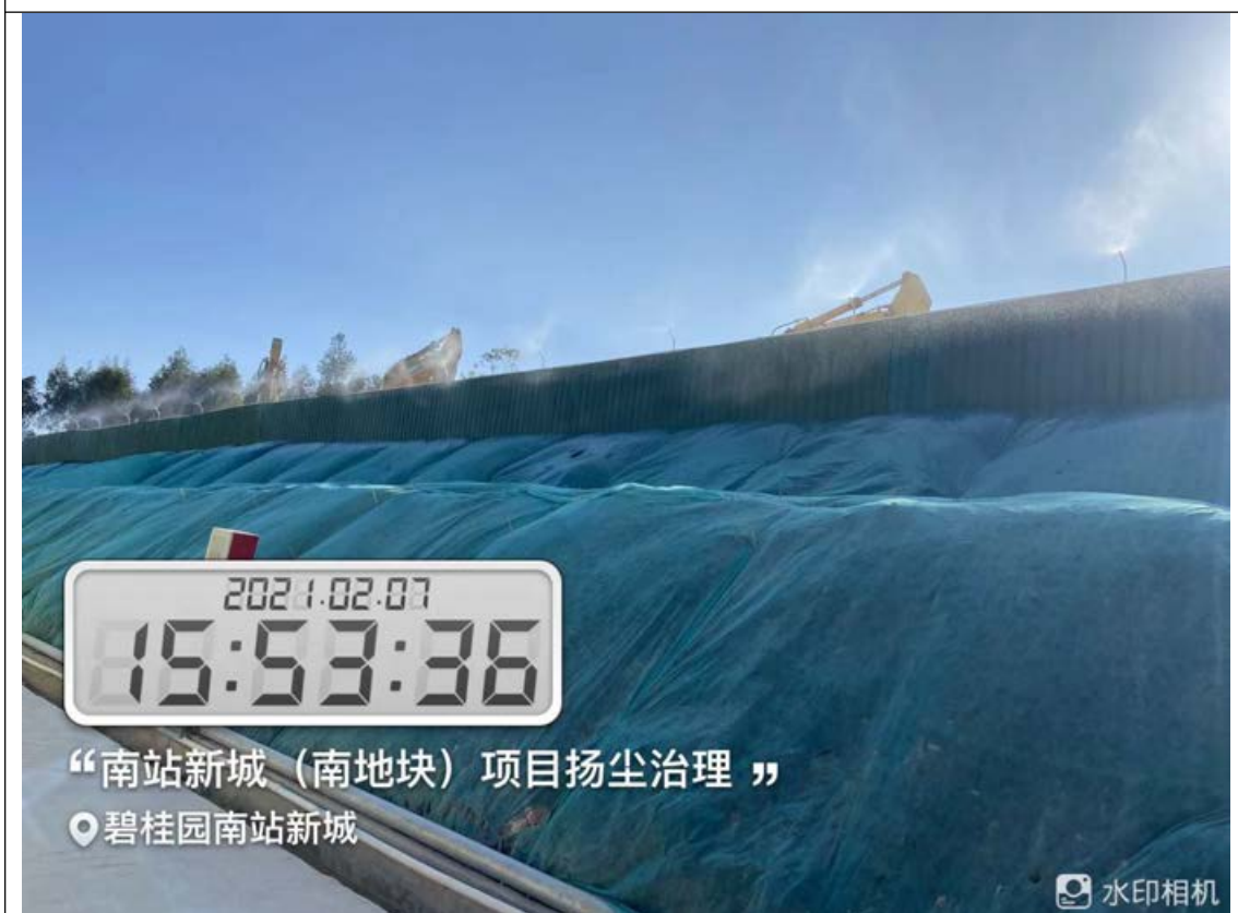
施工场地覆盖防尘网
