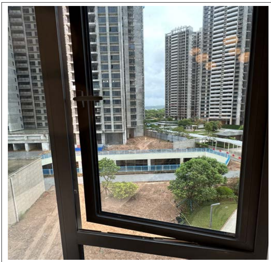
图 4.2-2 隔声窗治理措施现场图
