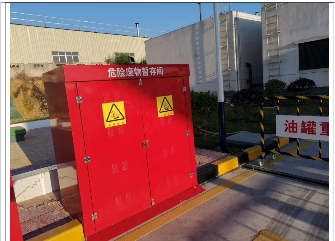
图 13 危废暂存间现场照片
