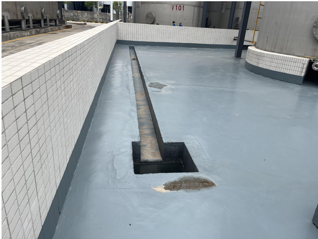
储罐区围堰、防渗及导流渠
