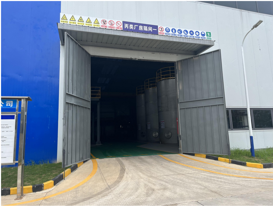
厂房门口缓坡/围堰
