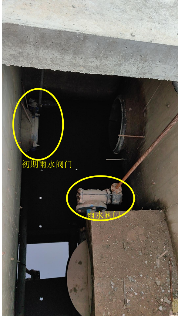
雨水阀门及初期雨水阀门
