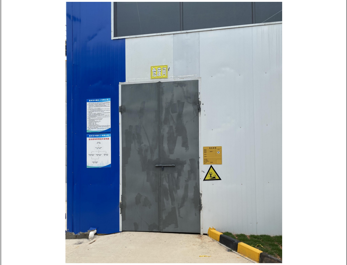
图 4.1- 6 危废暂存场所现场图
