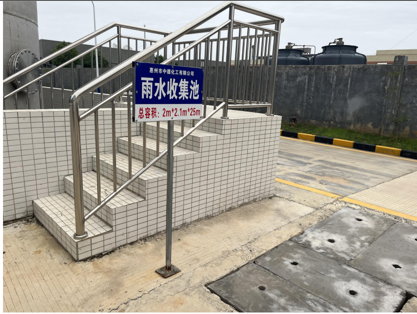
初期雨水收集池
