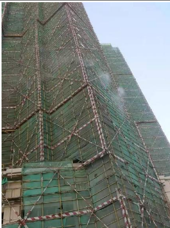
塔吊喷淋系统
