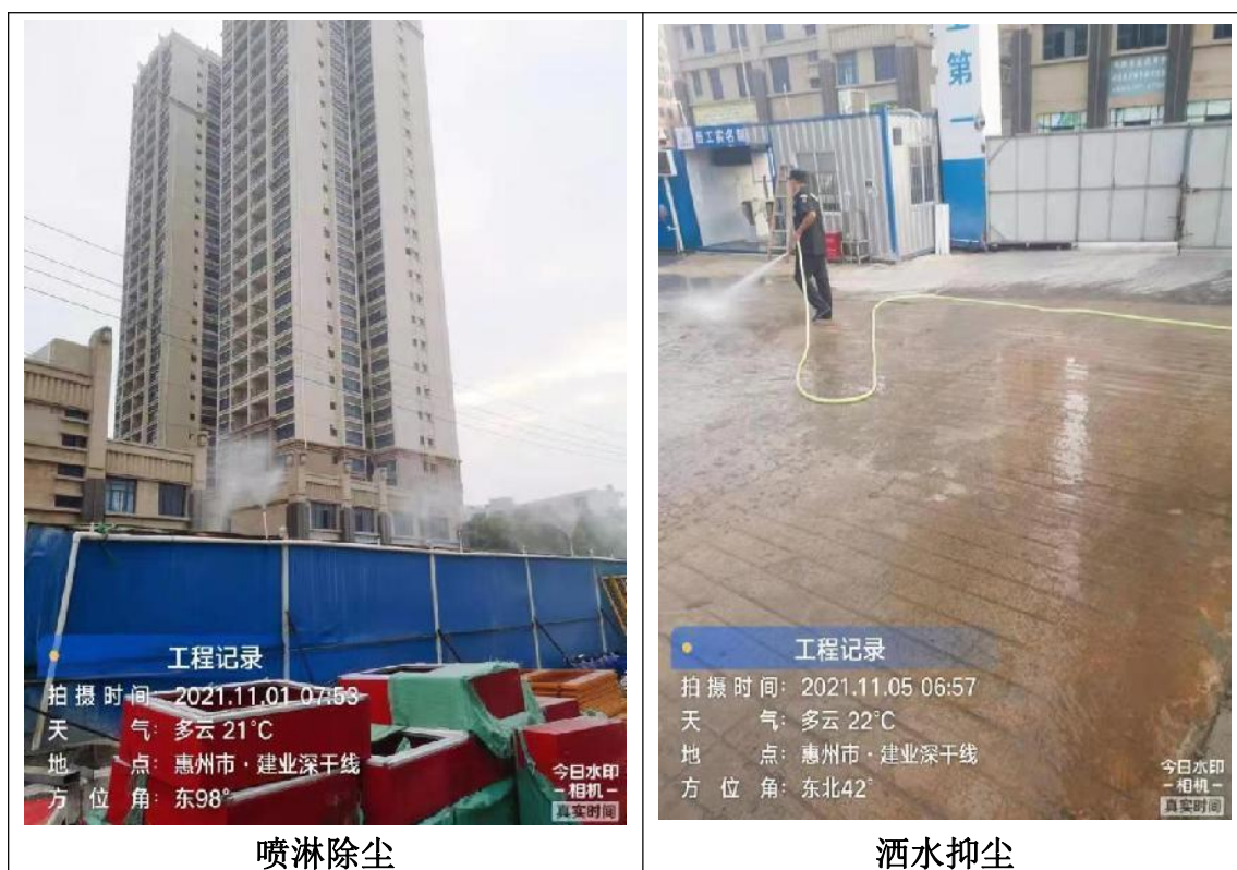
图 4.1-1 施工期环保措施现场图
