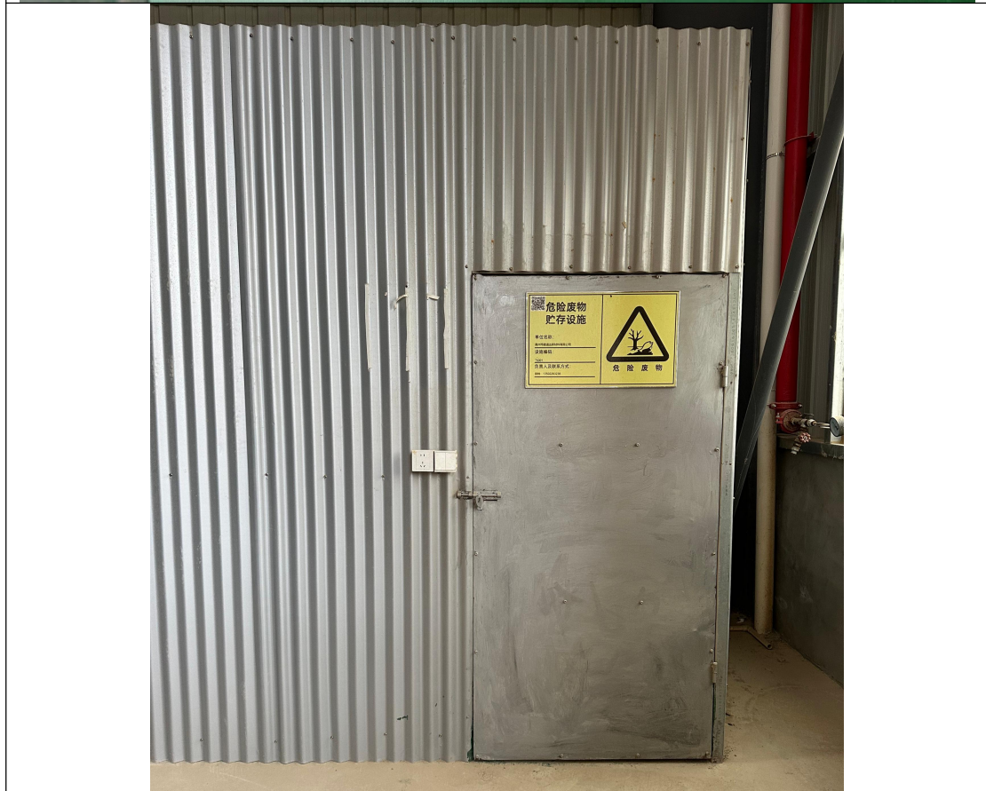
图 11 危废暂存间现场照片
