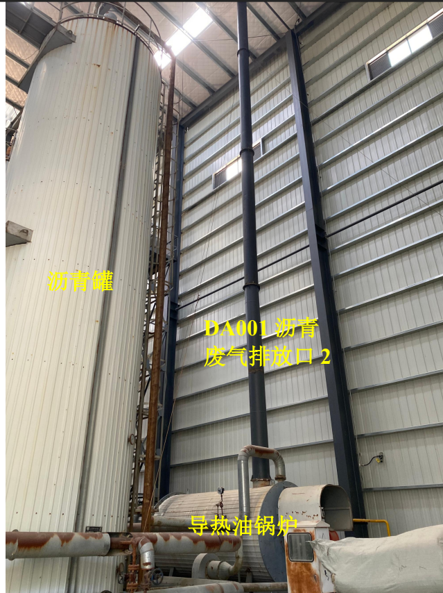
导热油锅炉及 DA001 沥青废气排放口 2
