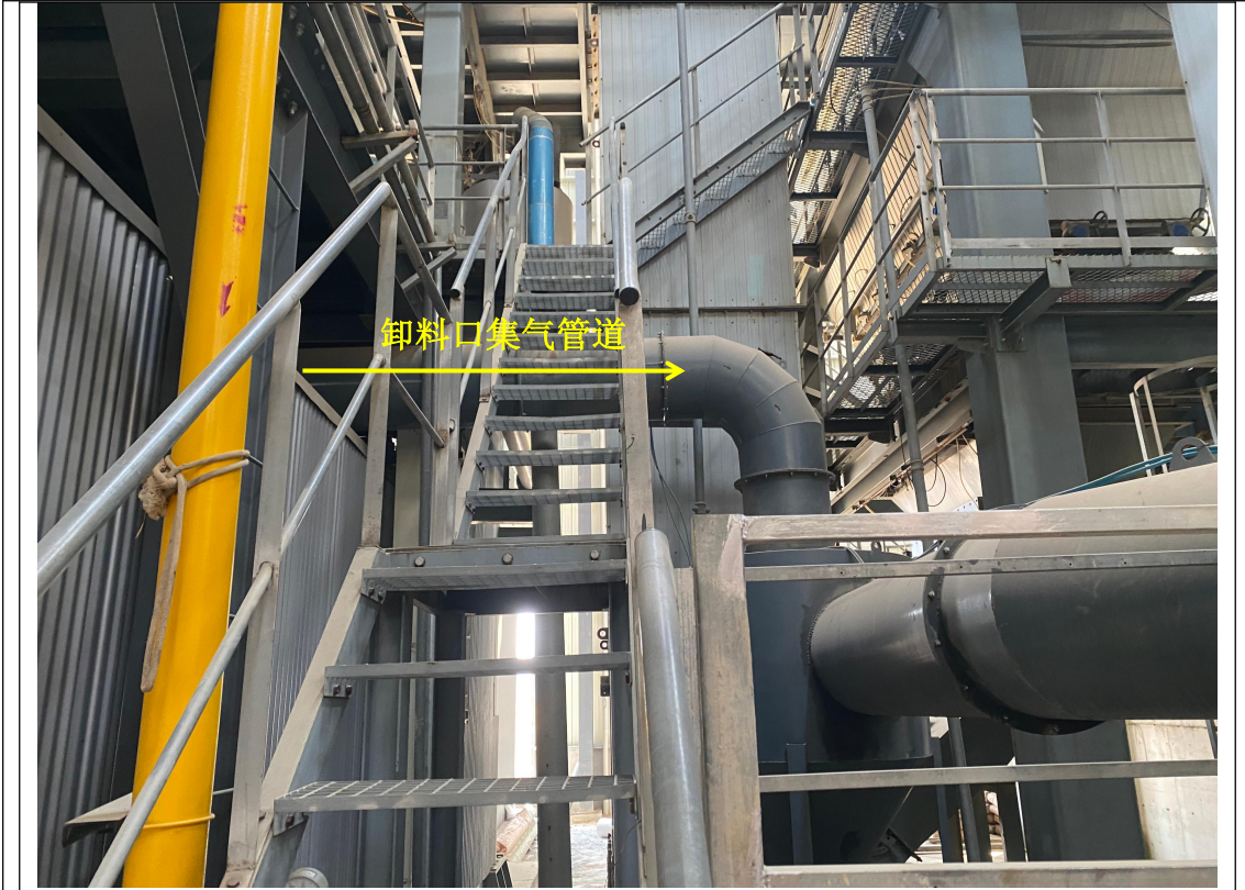
成品沥青卸料口集气管道现场照片
