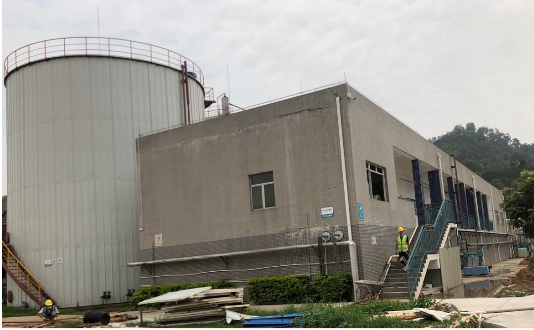
废水处理设施现场照片
