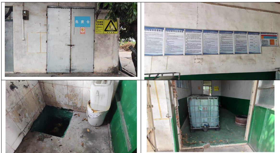
图 9 危废间现场照片
