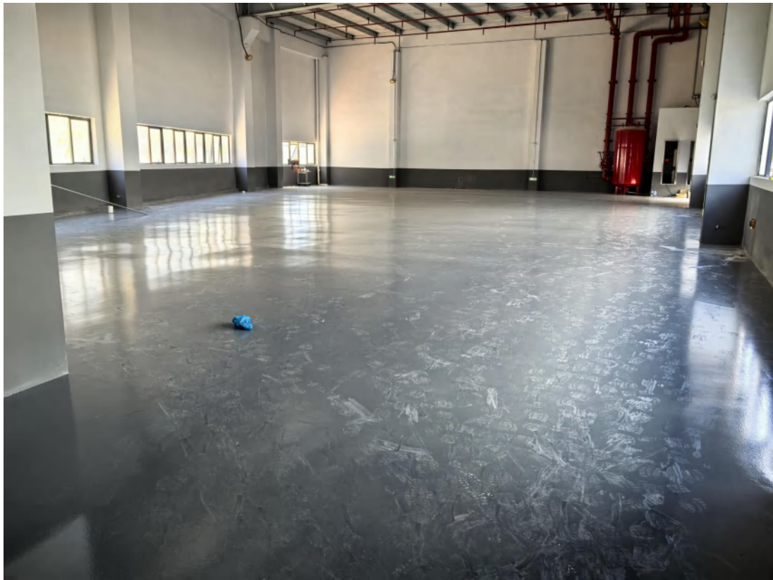
化学品仓库地面防渗漏
