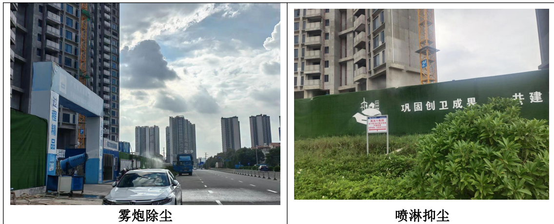
图 4.1-1 施工期环保措施现场图
