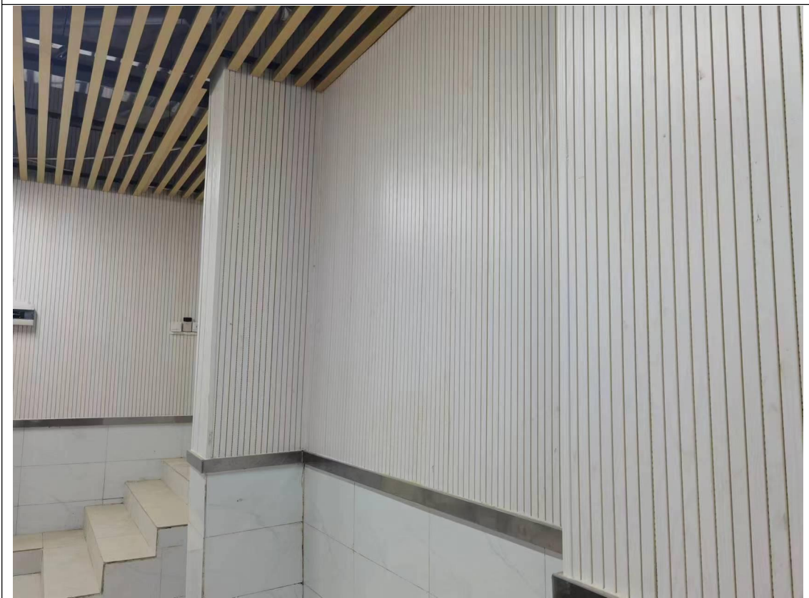
发电机房隔音墙体
