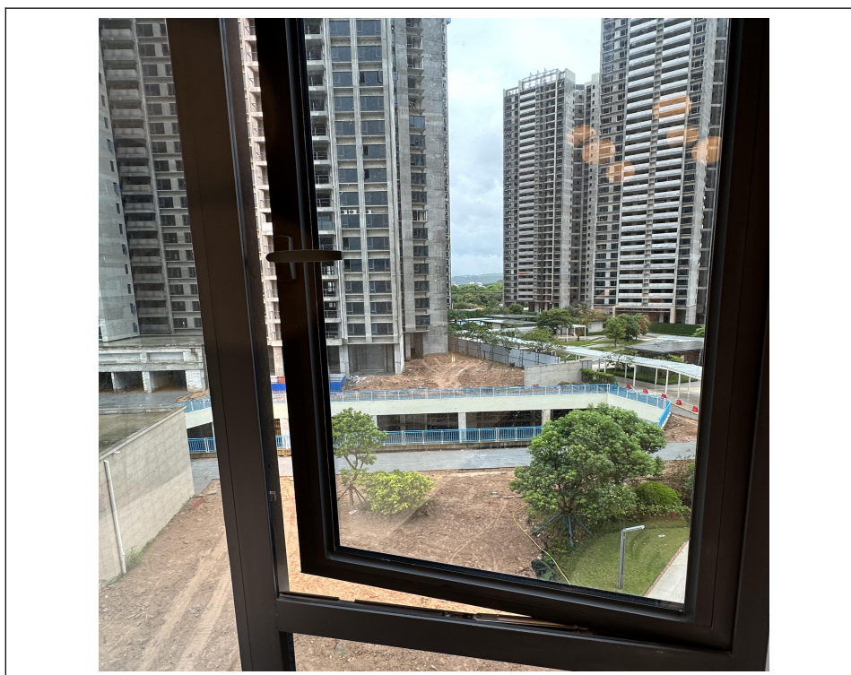
图 4.2-3 隔声窗治理措施现场图
