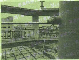
DA001 有机废气处理前取样口
