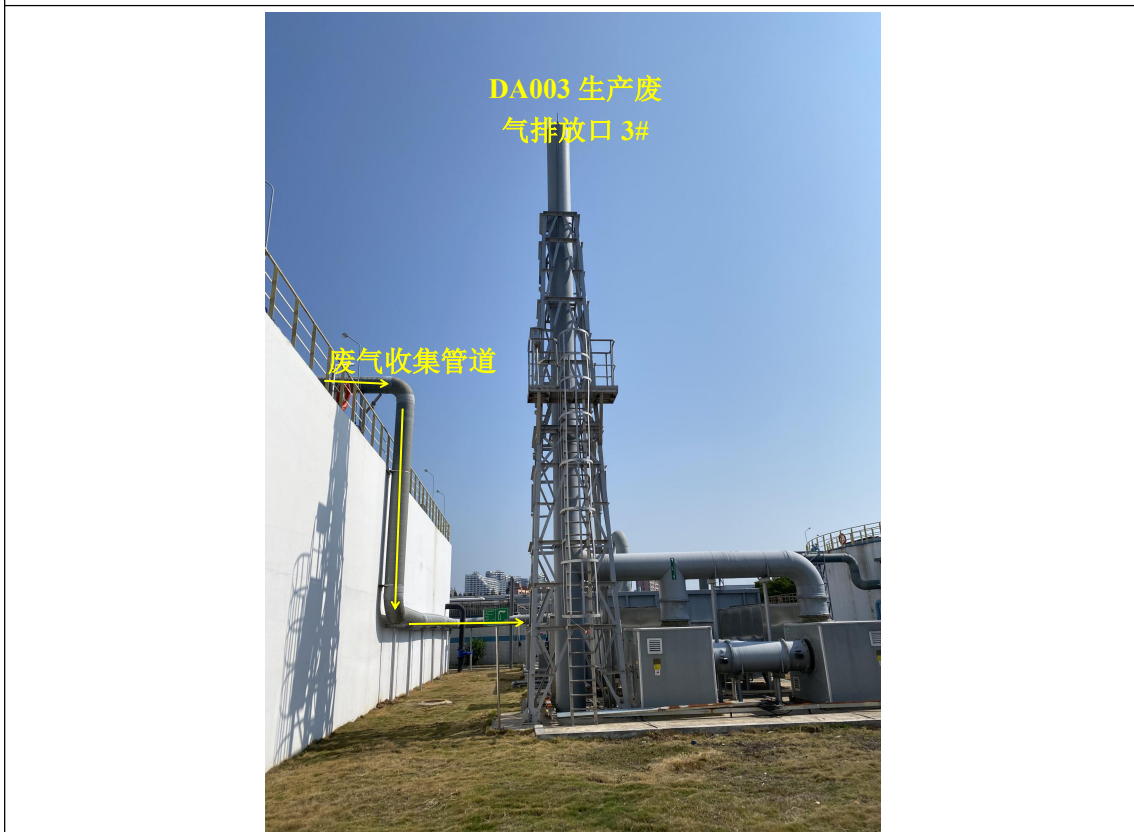
DA003 废气处理设施、收集管道及标识牌
