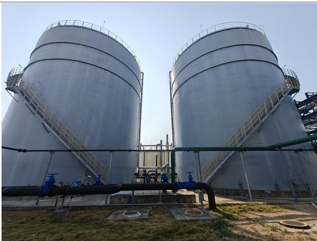
调节罐、事故罐及污水提升池
