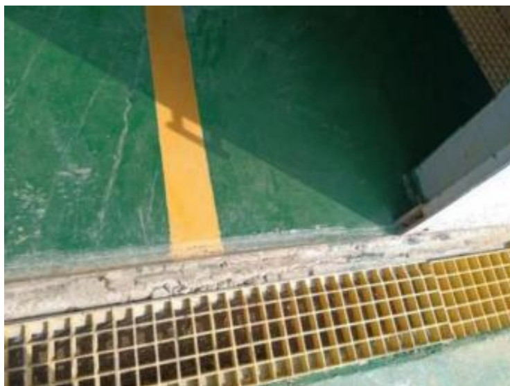
污泥贮存间防泄漏收集沟
