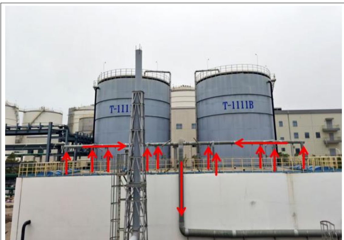
水解酸化池废气收集
