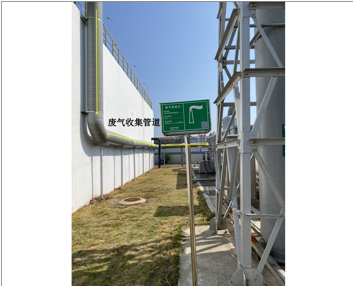
DA003 废气处理设施、收集管道及标识牌
