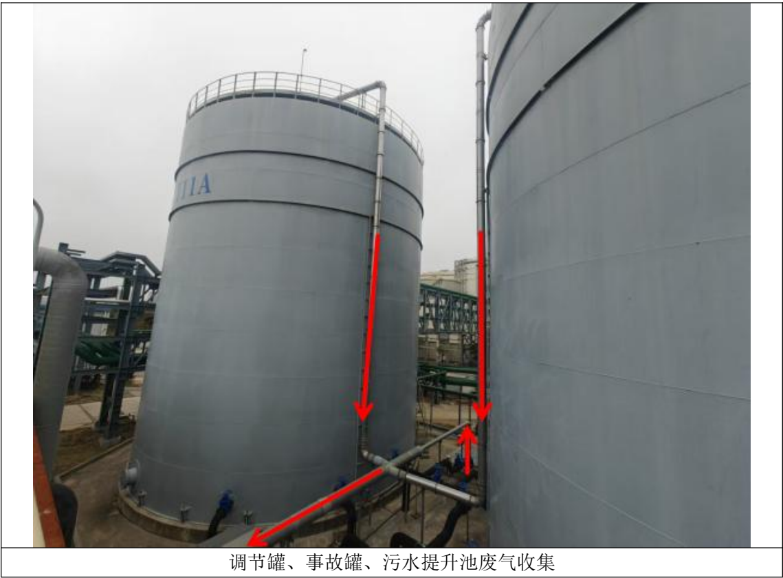
图 4.2-2 DA003 废气处理工艺流程
