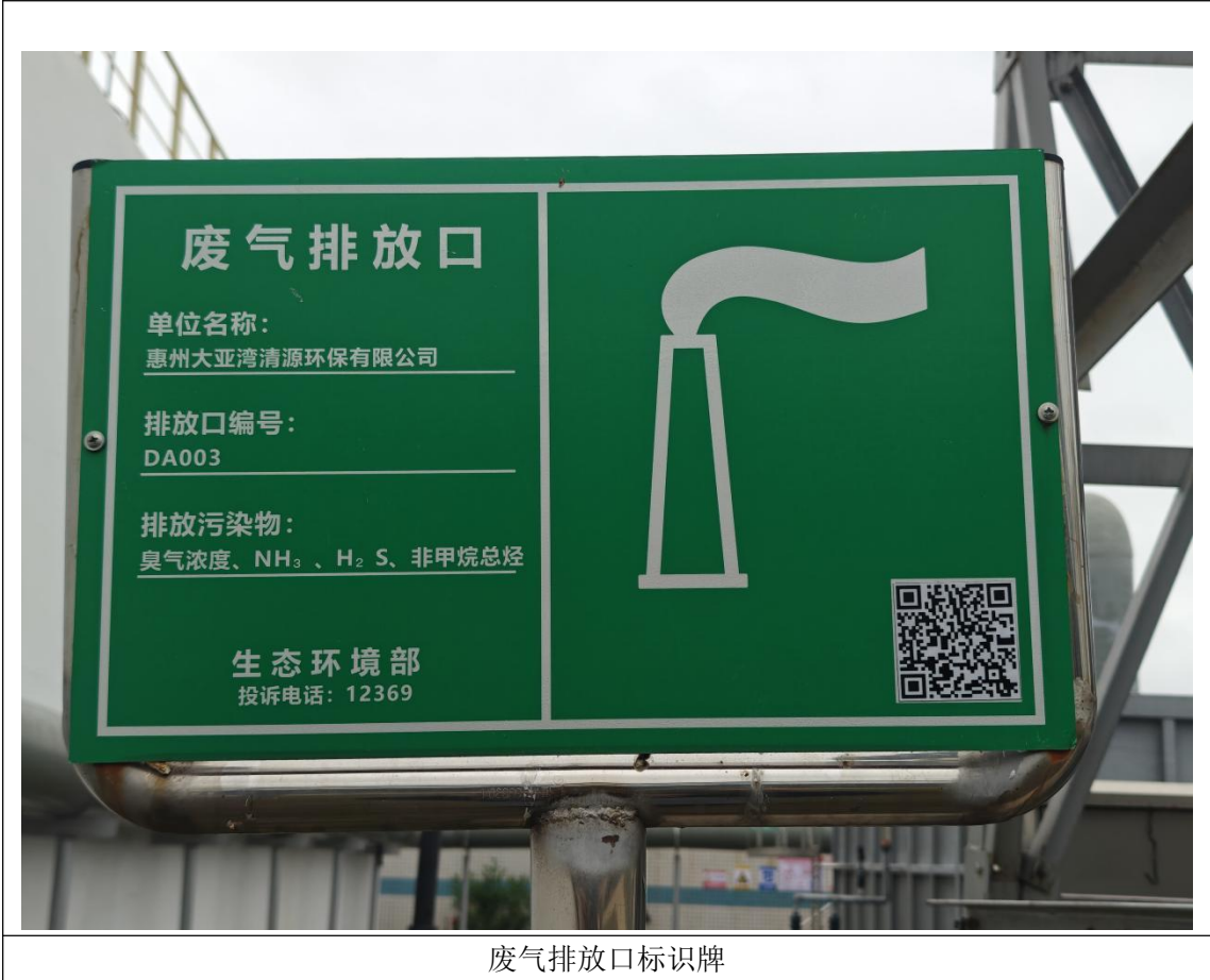
图 4.2-5 废气防治设施现场照片
