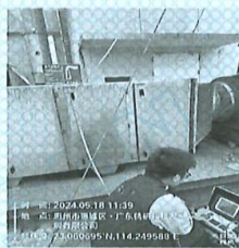
图 27: DA001 废气处理后采 样口 (2024.05.18 第 3 次)
