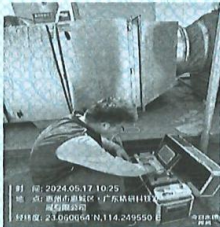
图 5: DA001 废气处理后采样口 (2024.05.17 第 2 次)
