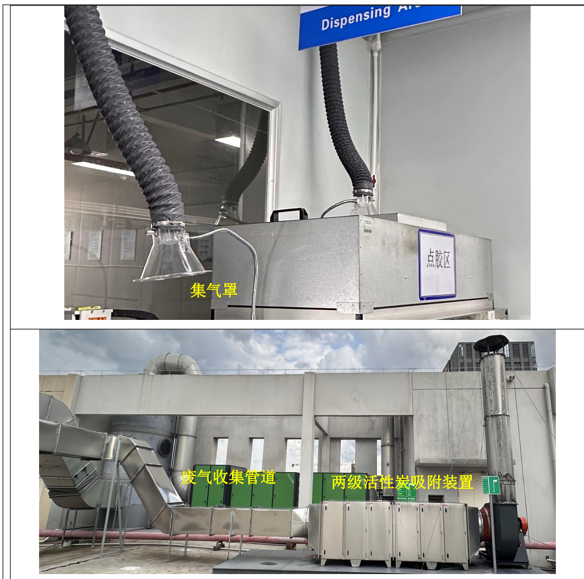
图 12 项目点胶工序产生有机废气收集及处理设施现场照片
