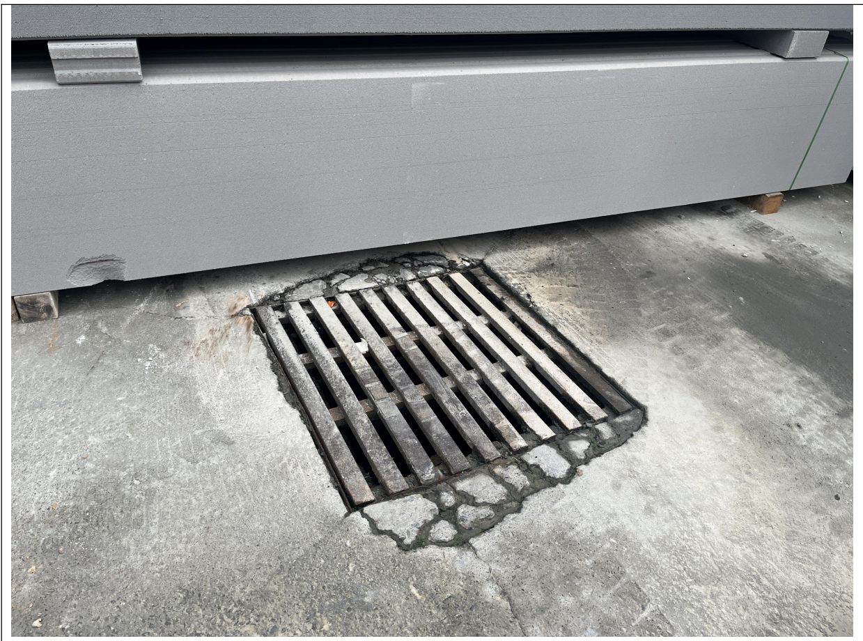
车辆清洗废水沉淀池
