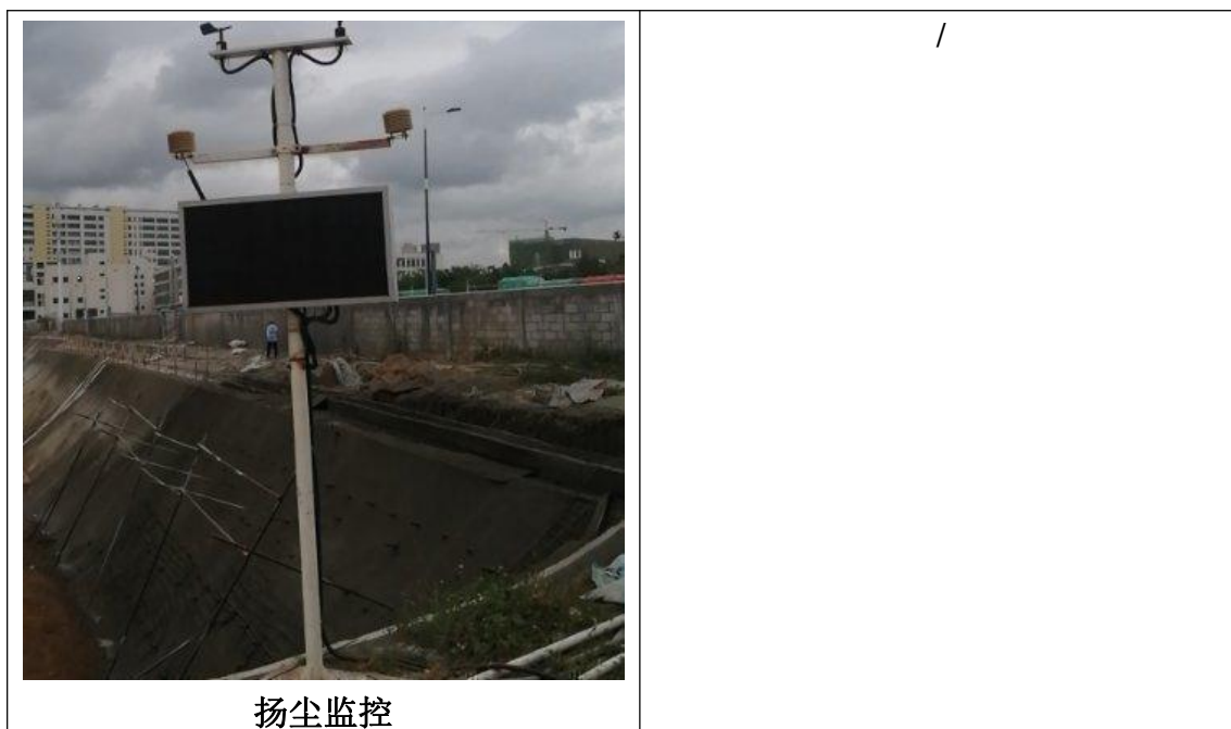
图 4.1-1 施工期环保措施现场图
