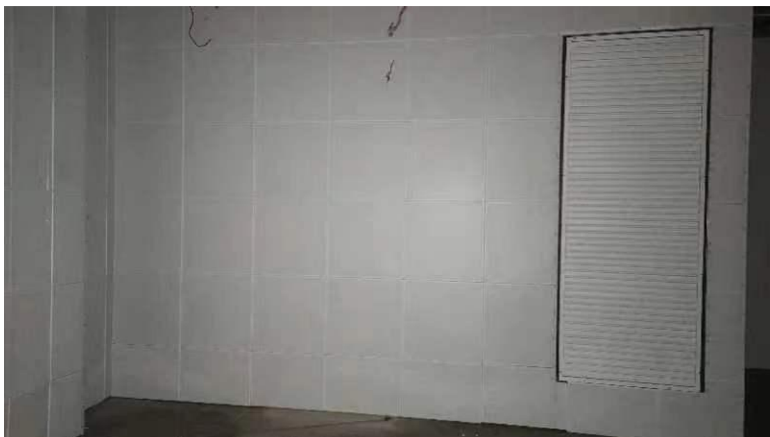
发电机房隔音墙体
