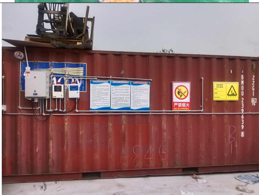
危险废物暂存间 图 10 危废暂存间现场照片
